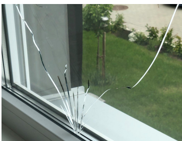
Abbildung 1: Thermisch induzierter Glasbruch an Fenster, Quelle:
